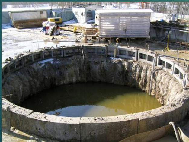
Состояние шахты ДО проведения работ
