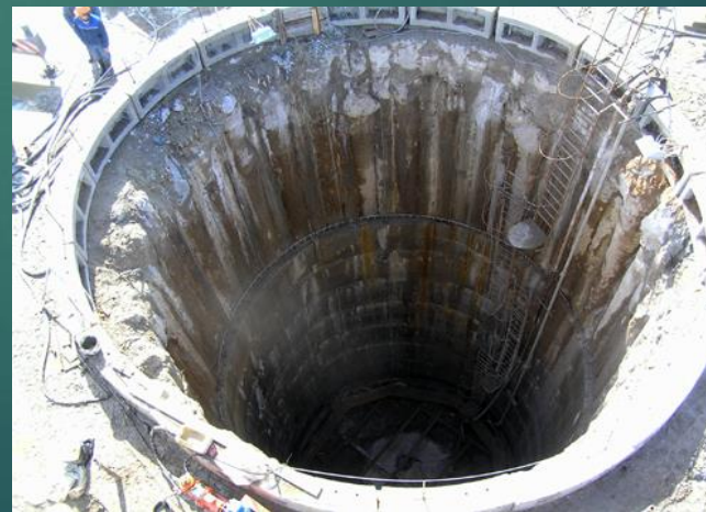
Состояние шахты ПОСЛЕ проведения работ
